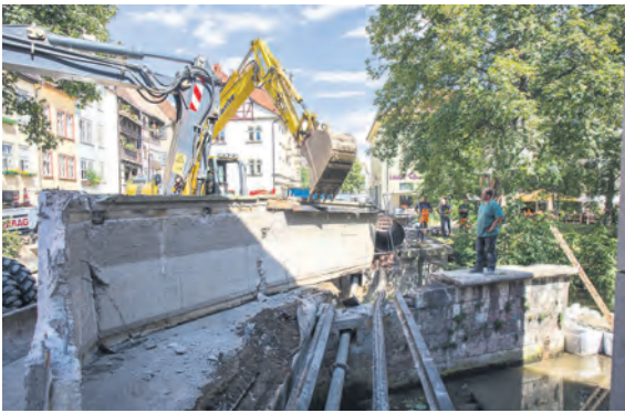
Im Februar wird mit dem Neubau der Rathausbrücken begonnen.
