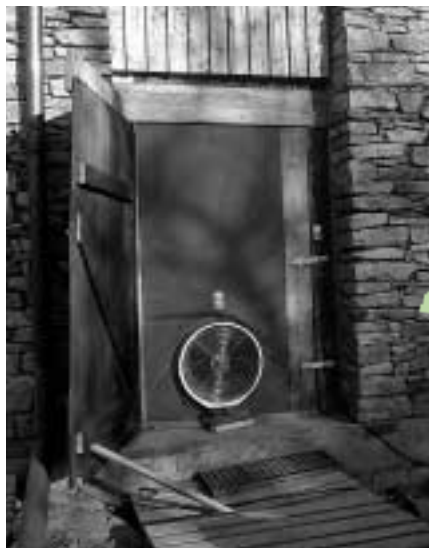
^ Blower door im Einsatz
