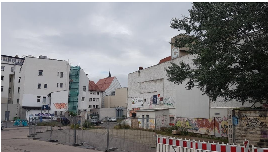
Abbildung 13 Foto von der Straße 'Reglermauer' zum Abrissgebäude (rechter Bildrand)
