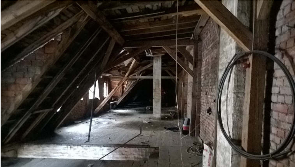
Abb. 6: Kontrollierter Dachstuhl im vorderen Gebäude (26. Juli 2017, Foto: J. Weipert)
