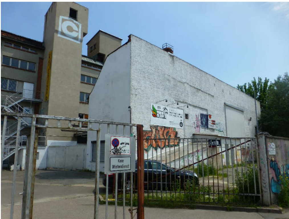
Abb. 1: Blick auf die beiden abzureißenden Gebäude im Planungsraum (2. Juni 2017, Foto: J. Weipert)
