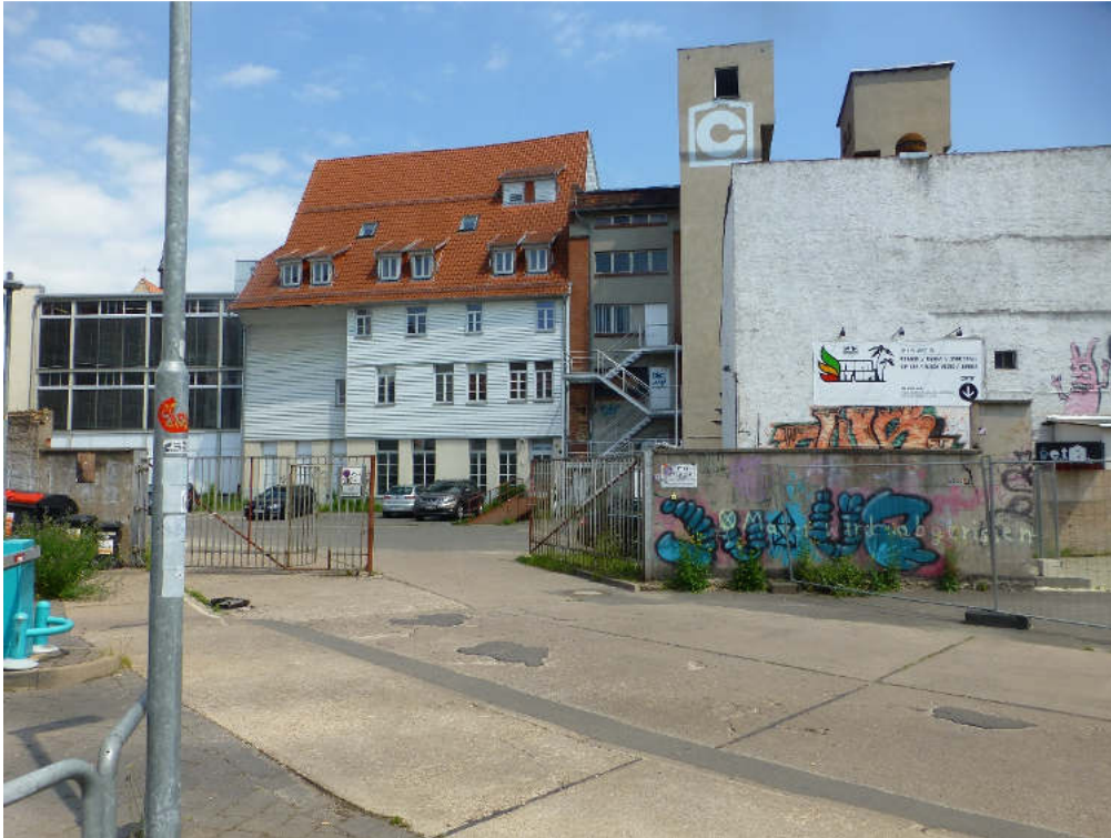
Abb. 2: Ansicht des Planungsraumes aus Südwesten mit benachbarter Bebauung (2. Juni 2017, Foto: J. Weipert)
