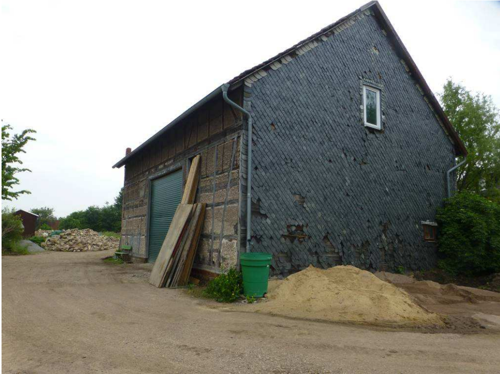
Abb. 15: Gebäude im Südteil des UG, Nähe Zufahrt, mit Quartiereignung für gebäudebewohnende Fledermäuse (27. Mai 2016, Foto: J. Weipert)
