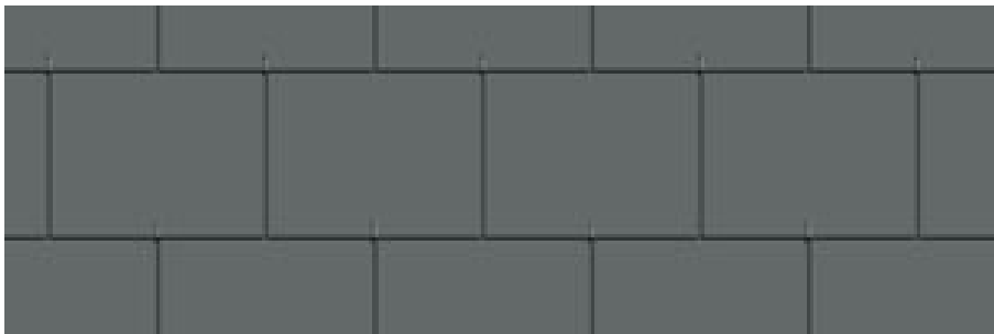
Faserzement-Dachplatten (Doppeldeckung)
