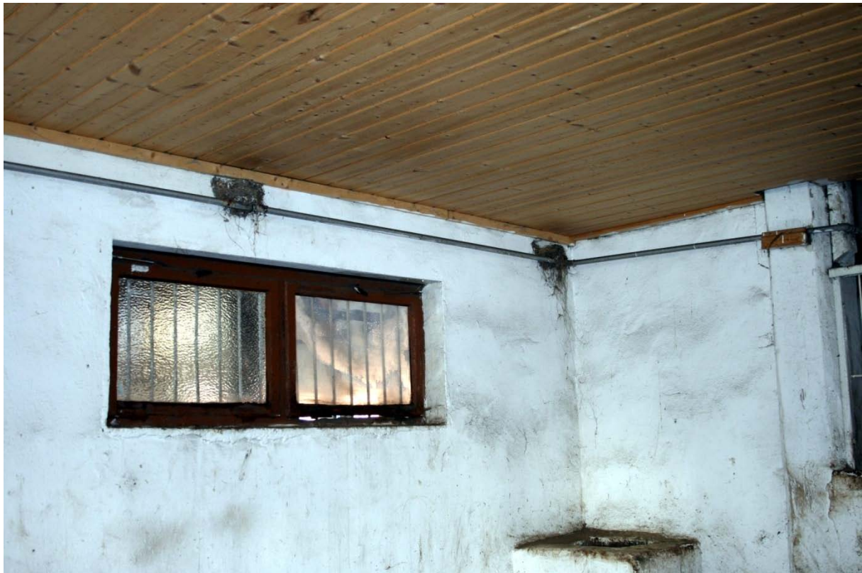
Rauchschalbennester im Stallbereich des Reithallengebäudes.
