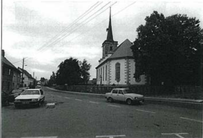
St. Lukas von Osten, wichtig : Erhalt der Naturstein ummauerung
