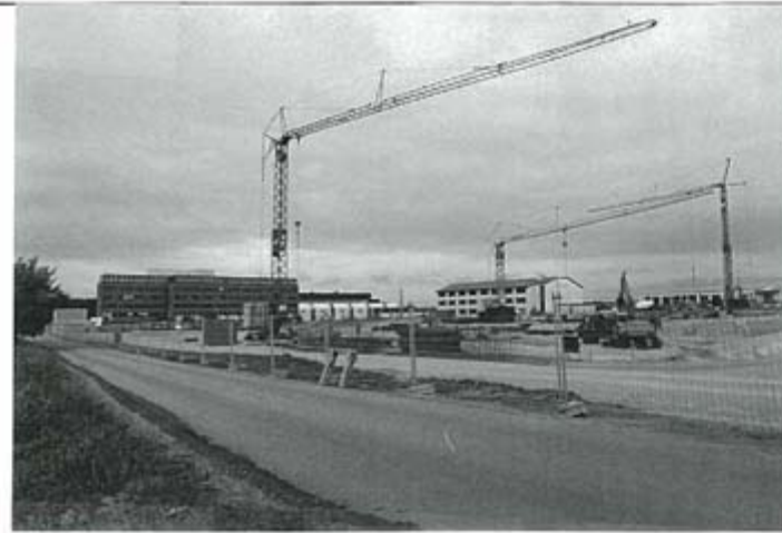
Druckzentrum sowie im Bau befindliches Berufsbildungszentrum der Handwerkskammer
