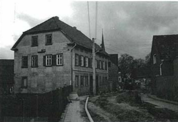
Flughafenstraße 70 : ortsbildprägend, aber sehr schlechter Bauzustand
