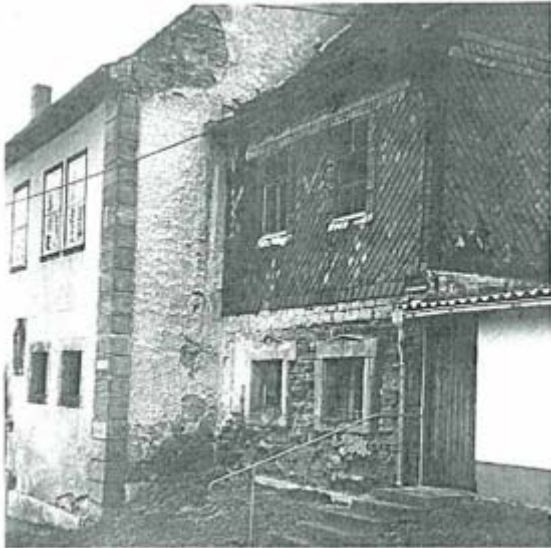
Die Domäne als ehemalige Klostergut prägt entscheidend das Ortsbild - derzeitige Nutzung und Bauzustand stehen im krassen Widerspruch dazu.
