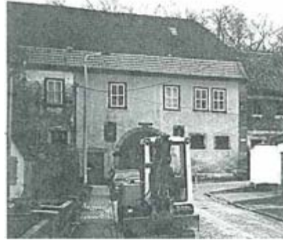
Hauptgebäude der Domäne mit unmittelbarer Wirkung in den Straßenraum der Ortslage Hochstedt.
