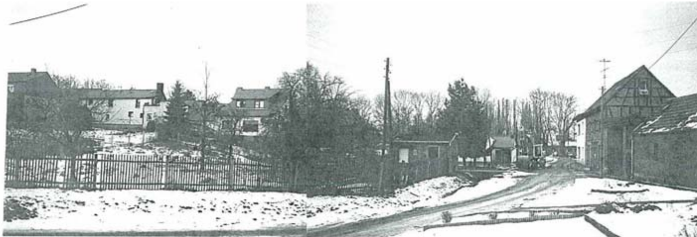
Straßenbereich am Bach zwischen Domäne und Kirchberg. Die vor Kanaleinbringung hier vorhandenen Uferbäume sind wieder zu pflanzen. Die Straßengestaltung (ehemals Pflasterung in Naturstein) sollte im Zuge komplexer Sanierungsmaßnahmen als Gestaltungsschwerpunkt betrachtet werden.
