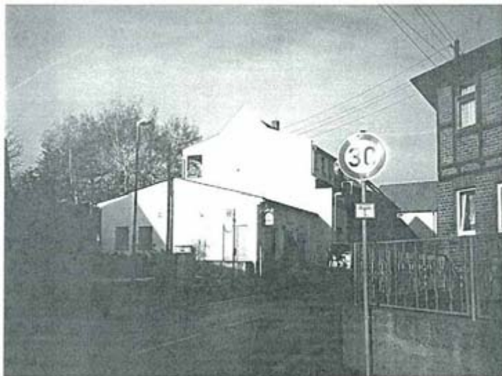
Gebäude an der Hauptstraße, deren ortsbildtypische Gestaltung mittels Fassadenbegrünung verbessert werden könnten.
