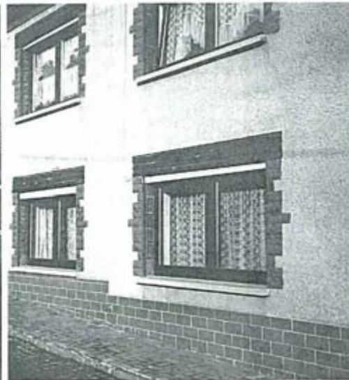
Beispiel für ortsuntypische Fassadengestaltung . Fensterformate / Fassadenverkleidungen / Rolläden, Sockel.
