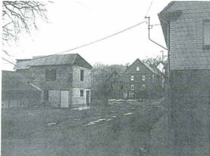
Vorhandene Bausubstanz im Bereich "Am Bach", die durch ihre derzeitige Gestaltung das Ortsbild sehr negativ beeinflussen. Umgestaltung vor allem des Dachbereiches notwendig.
