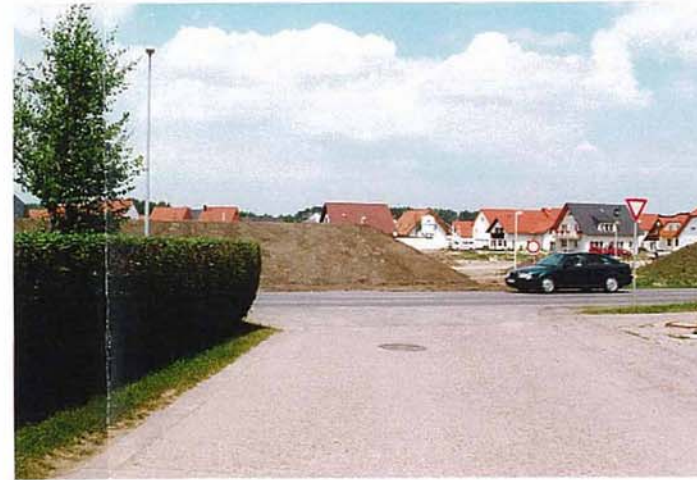
Blick auf den Lärmschutzwand von der Feldstraße
