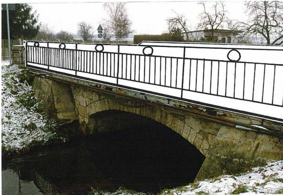
Die steinerne Brücke steht unter Denkmalschutz, das Geländer sollte eine dem entsprechende Form erhalten
