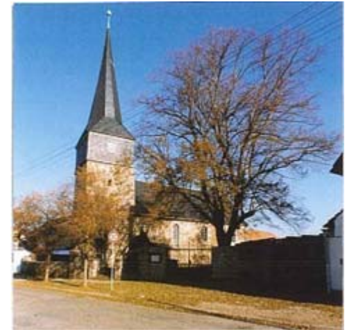
Abb. 4 Denkmalgeschützte ev. Pfarrkirche mit kleinem Vorplatz und Bushaltestelle
