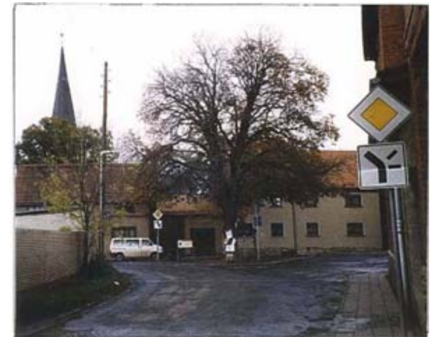
Abb. 14,15 Straße des Friedens Anger Der Verknüpfungsbereich ist gestalterisch und funktionell aufzuwerten. Der Brunnen mit Pumpe sollte integriert werden.
