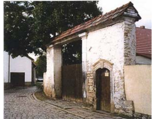
Abb. 12, 13 Lindenstraße 10 Sanierungsbedürftiges Portal mit Tor und Mauer
