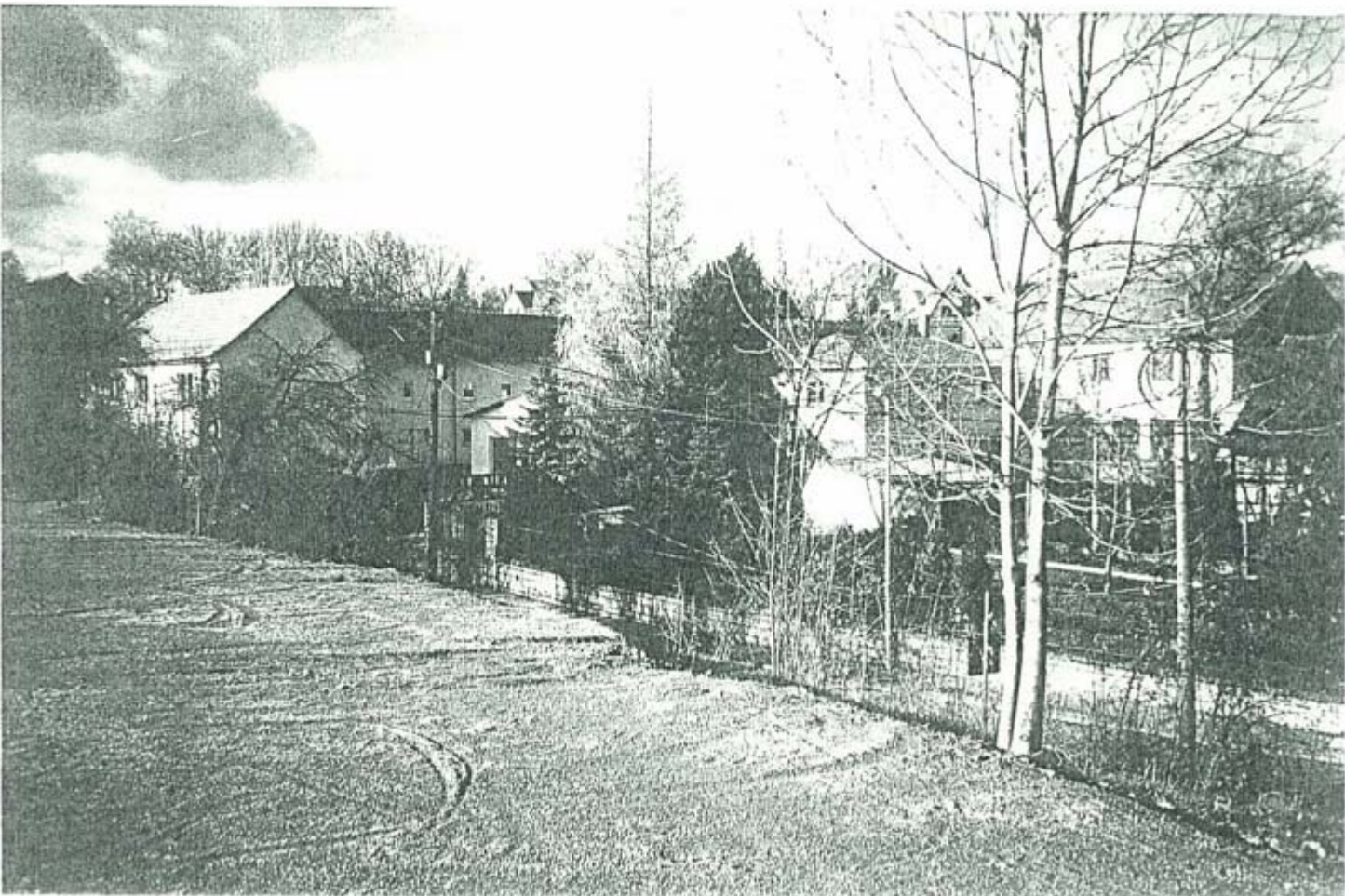
Plateaugrundstück und Randbebauung H.-Müller-Straße
