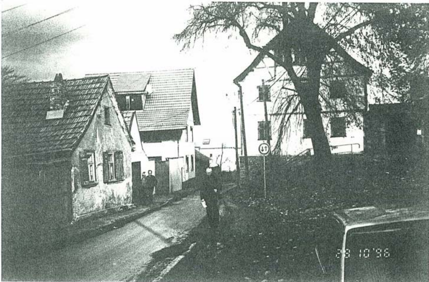
H.-Müller-Straße: sanierte und zu sanierende Gebäude
