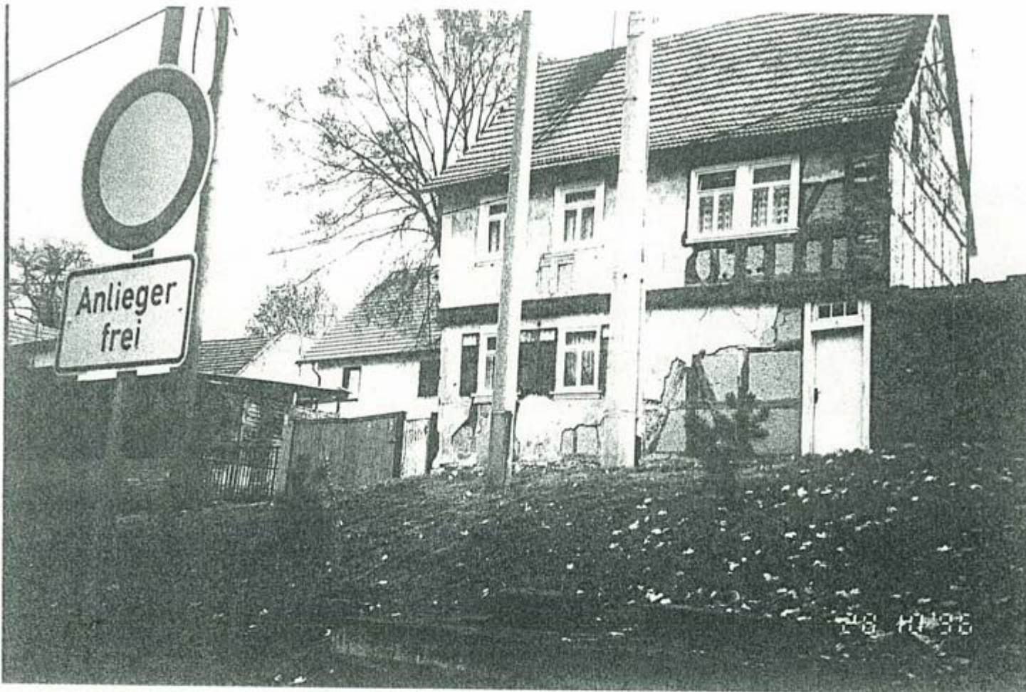
Die grüne Böschung und zu sanierende Gebäude am Käferberg
