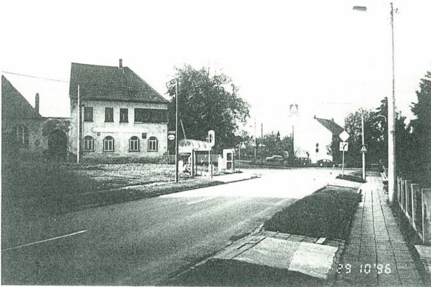
Schwarzenburger Straße: Begrünung fehlt, Brandwand, kann angebaut werden
