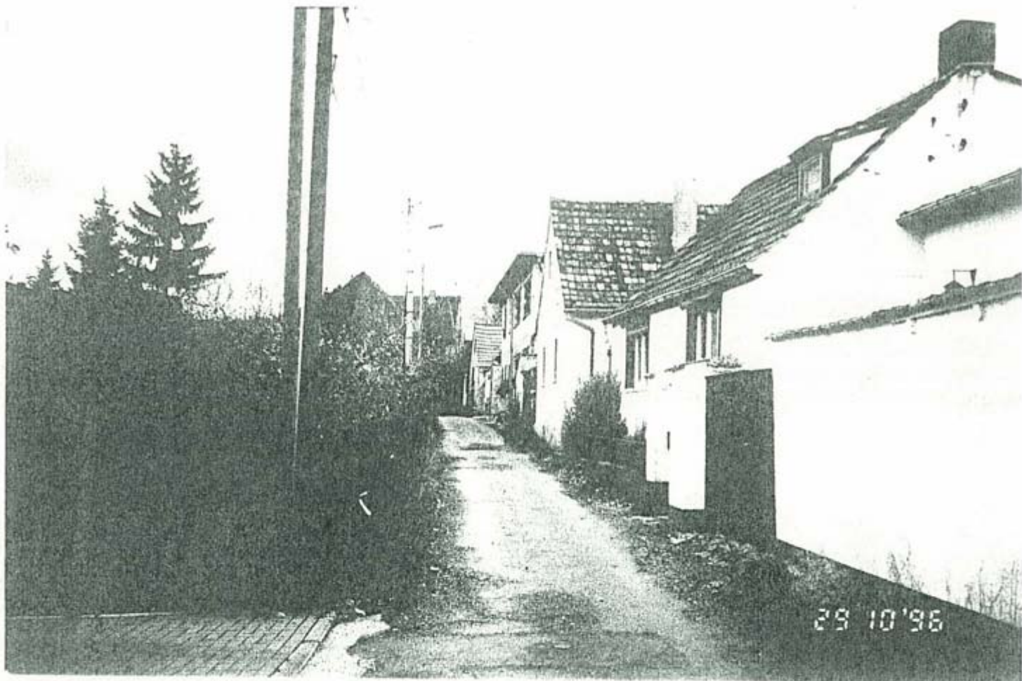
Gartenstraße: Unattraktive Straßenoberfläche
