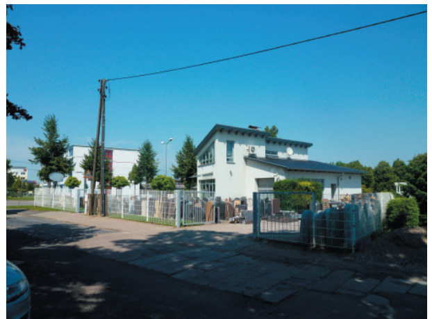
Zu erhaltender Steinmetzbetrieb am nordwestlichen Rand
