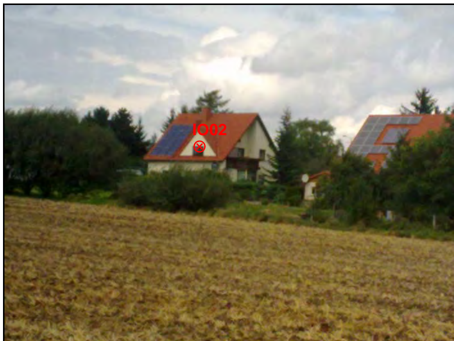
IP02 – Urbich, Bäckerberg 8 - Ansicht Wohnhaus (WA)
