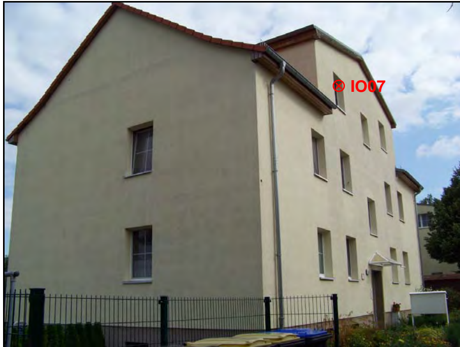
IO07 - Urbich, Nachtigallenweg 3 - Ansicht Wohnhaus (MI)
