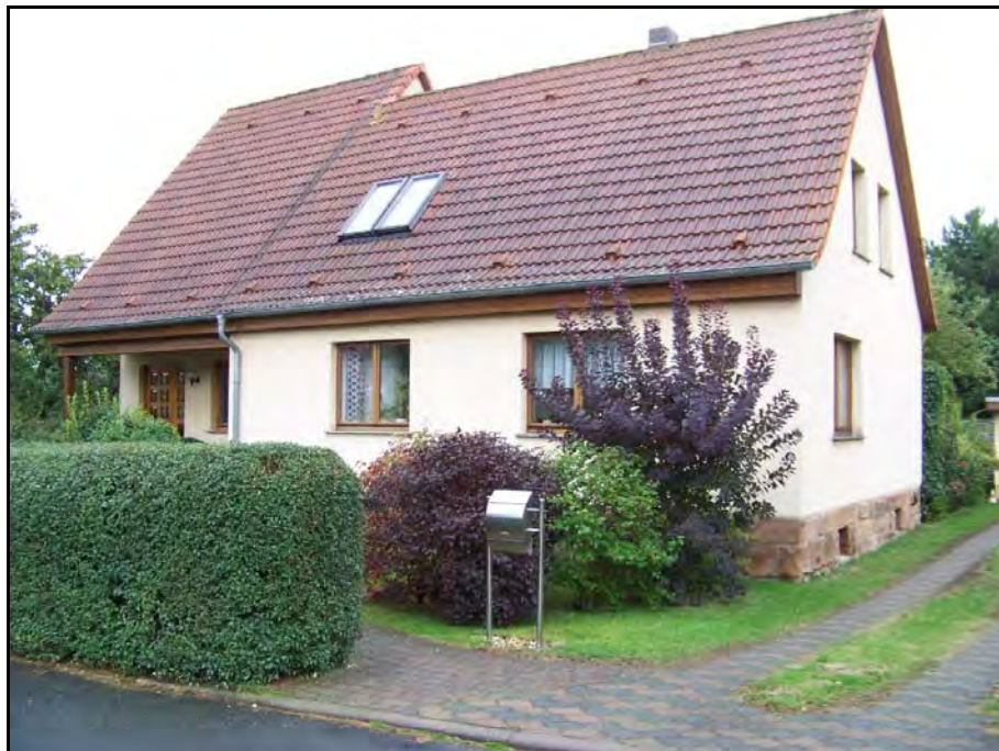
IP03 – Urbich, An der Kochschule 1a - Ansicht Wohnhaus (WA)
