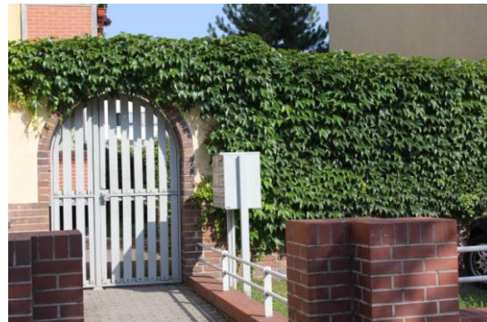
Abb. 88: Hamburger Straße - sanierter Eingangsbereich
