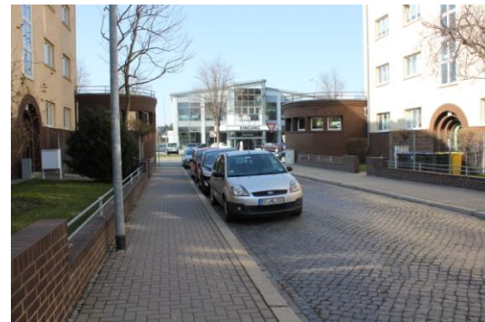
Abb. 84: Bremer Straße - Erhalt der vorhandenen Natursteinpflasterung im Fahrbahnbereich
