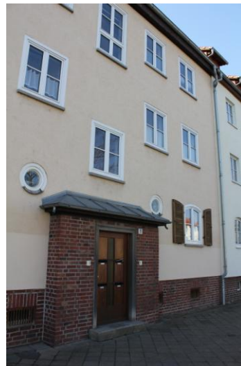
Abb. 56: Greifswalder Straße - saniertes Wohnhaus
