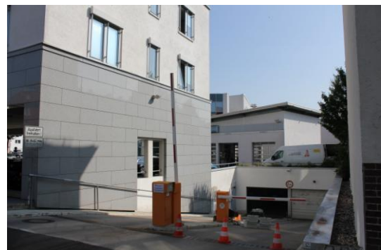
Abb. 141: Altonaer Straße - Private Tiefgarage
