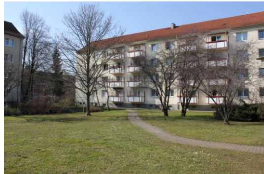
Abb. 54: Emdener Straße - sanierte Wohnanlage
