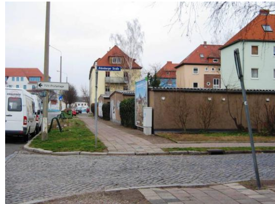
Abb. 34: Garagenanlage Ecke Schlachthof-/ Oldenburger Straße
