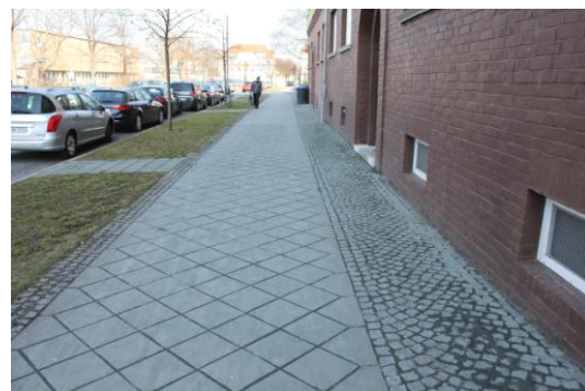
Abb. 90: Greifswalder Straße - Neugestalteter Gehweg mit Betonplatten, Naturstein-Mosaikpflaster und Grünstreifen mit Baumreihe
