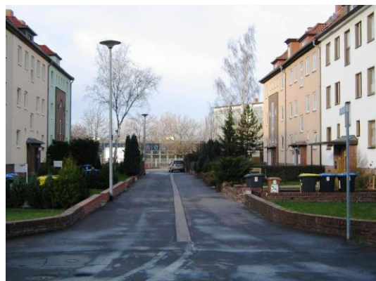
Abb. 42: Helgoländer Weg - Tiefe Vorgärten mit untypischer Gestaltung mit Koniferen
