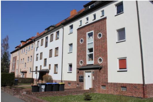
Abb. 53: Helgoländer Wege - sanierte Wohngebäude
