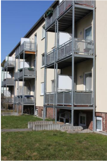
Abb. 57: Helgoländer Weg - Neubau der Balkonanlagen
