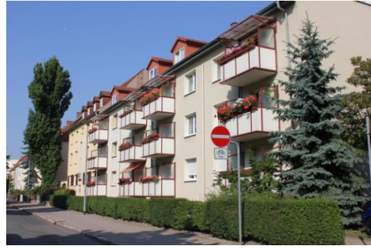
Abb. 52: Hamburger Straße - sanierte Wohngebäude
