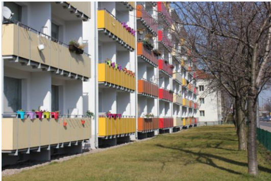
Abb. 55: Leipziger Straße - saniertes Wohnhaus
