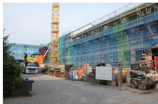
Abb. 70: 2015: Umbau und Sanierung Haus 6 einschließlich Campus-Mensa
