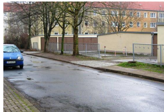
Abb. 26: Garagenanlage Rostocker Straße
