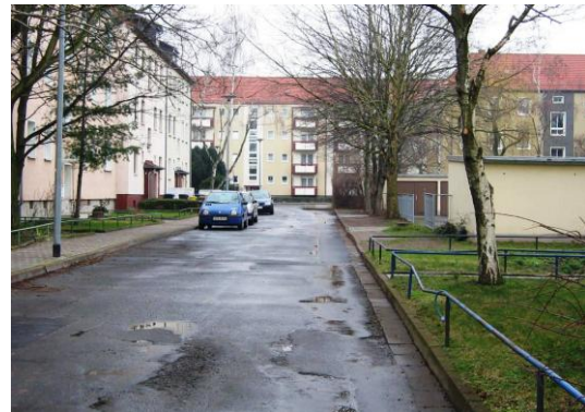
Abb. 8: Wohnquartier Rostocker Straße
