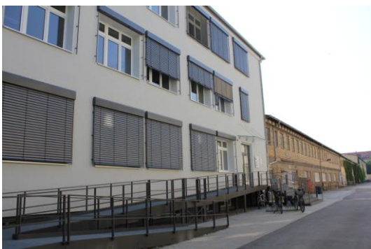
Abb. 69: Neu saniertes Nebengebäude der Fachhochschule; im Hintergrund: noch sanierungsbedürftige Nebengebäude
