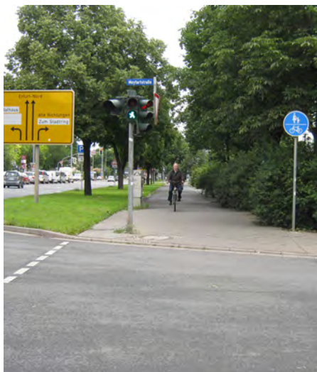
Juri-Gagarin-Ring/Meyfartstraße Führung auf bestehendem Weg; Borde besser absenken; Geh-/Radweg durch Markierung oder Materialwechsel trennen; Radweg für Zweirichtungsverkehr vorsehen; ggf. Verbreiterung in die Grünfläche
