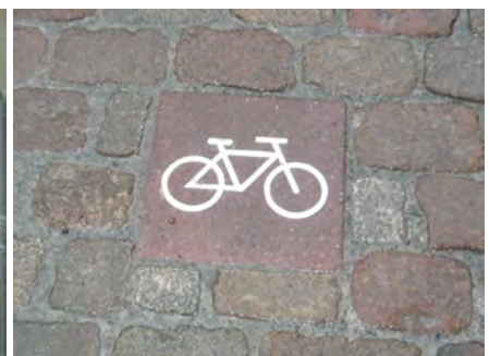
Beispiel Potsdam Detaillösung Strecke: Verwenden von Formsteinen mit Radfahrerpiktogrammen für Pflasterbeläge
