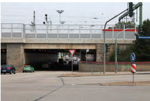
Östliche Tunnelröhre – Blick aus Richtung Süden
