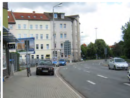
Stauffenbergallee zwischen Magdeburger Allee und Liebknechtstraße Entfernen der Parkstände
