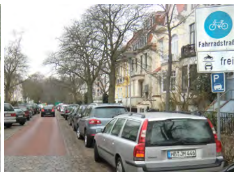
Beispiel Bremen (Benquestraße) Fahrradstraße mit asphaltierter und rot markierter Fahrgasse
