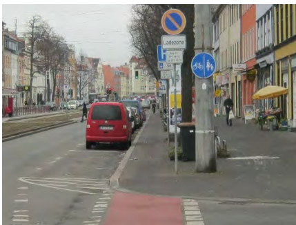
Magdeburger Allee/Bebelstraße Parkflächen und Radweg tauschen; Borde zum Parken anschrägen; Radfahrstreifen markieren
