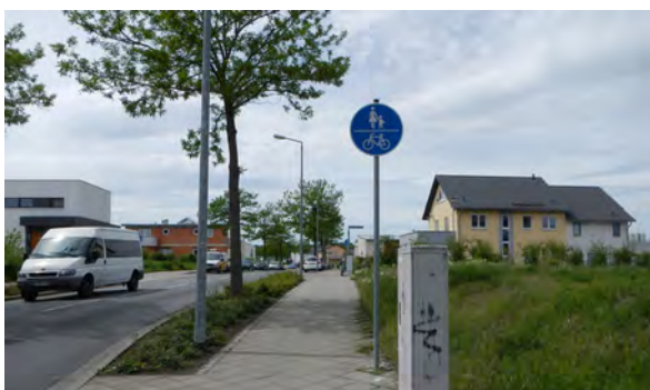
Beispiel Erhard-Etzlaub-Straße Aufhebung der Benutzungspflicht des gemeinsamen Rad- und Gehweges
