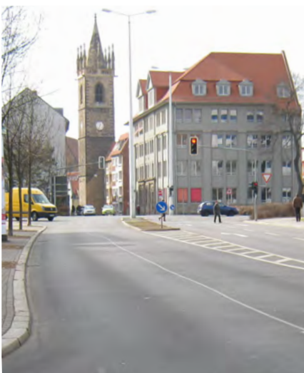
Franckestraße zwischen Juri-Gagarin-Ring/Stauffenberg- allee: beidseitig Schutzstreifen anlegen; Gehweg/Radverkehr frei
