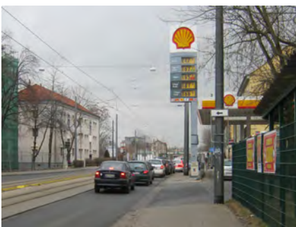
Leipziger Straße Grundstückszufahrt mit bituminösem Belag und starker Nutzung; Sicherung mit flächiger roter Einfärbung
