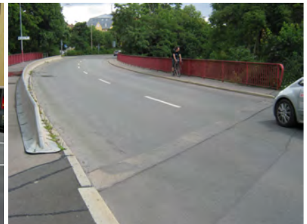
Schlüterstraße/Gerabrücke Radfahrstreifen in Fahrtrichtung der Einbahnstraße
