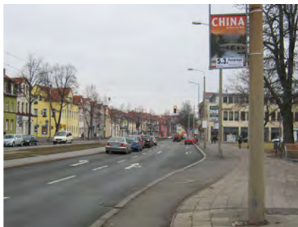
Magdeburger Allee/Eislebener Straße ggf. Rechtsabbiegestreifen für Kfz aufgeben, sonst geradeausfahrenden Radverkehr in Rechtsabbiegestreifen mitführen
