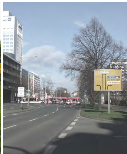
Juri-Gagarin-Ring/Meyfartstraße direktes Linksabbiegen vom Juri-Gagarin-Ring in Richtung Innenstadt ermöglichen; Radfahrstreifen frühzeitig „öffnen“ und Schutzstreifen in Kfz-Linksabbiestreifen markieren
