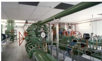
SWE Gasversorgung Foto: SWE Stadtwerke Erfurt GmbH
