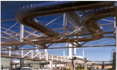
Foto: SWE Stadtwerke Erfurt GmbH
