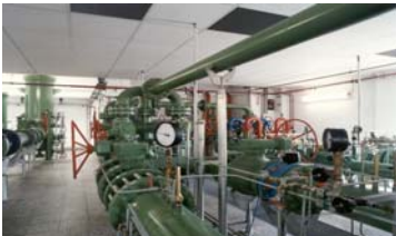
SWE Gasversorgung Foto: SWE Stadtwerke Erfurt GmbH
