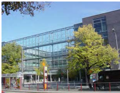
Foto: SWE Stadtwerke Erfurt GmbH
