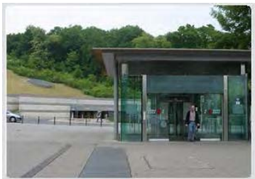
Foto: SWE Stadtwerke Erfurt GmbH
