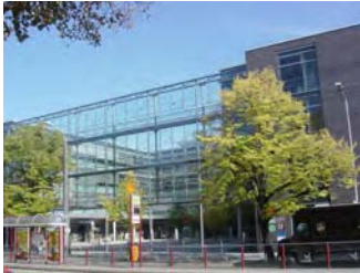
Foto: SWE Stadtwerke Erfurt GmbH
