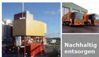
Foto: SWE Stadtwerke Erfurt GmbH
