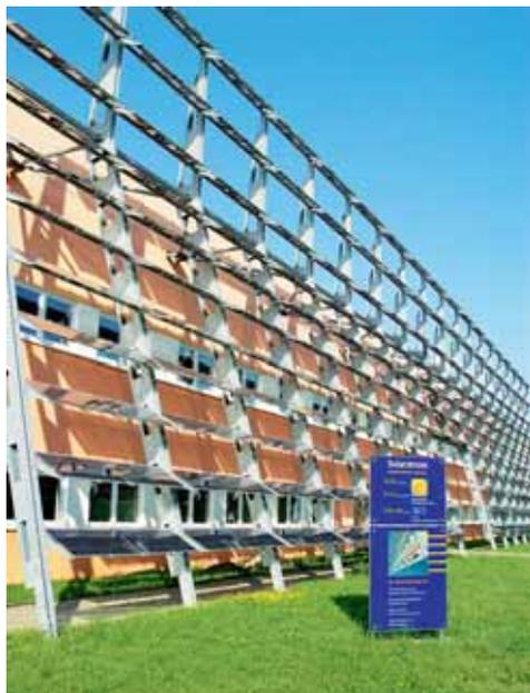
Bild 5 (© AEP Energie-Consult GmbH): PV-Anlage in Erfurt Südost am Gebäude der PV Crystalox Solar GmbH (30 kWp)
