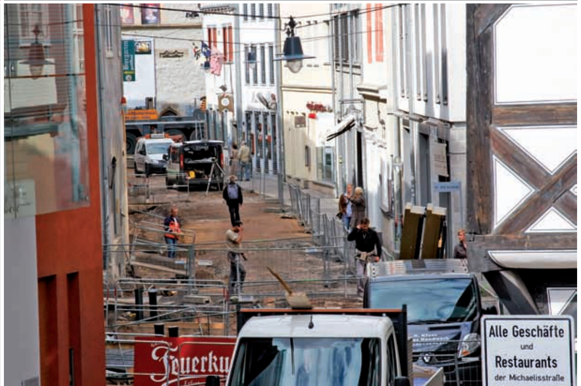
Baustelle Michaelisstraße – trotz der umfangreichen Maßnahmen sind alle Geschäfte und Restaurants sowie die Alte Synagoge erreichbar und geöffnet.
