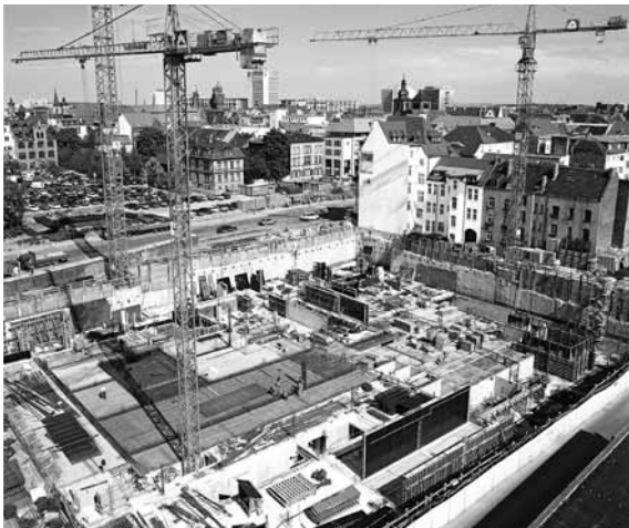
Baustelle: Der Juri-Gagarin-Ring im Jahr 1995
