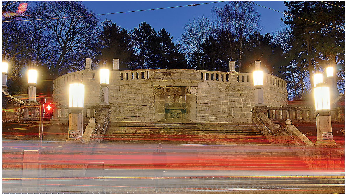
Die denkmalgeschützte Jugendstilanlage wurde umfassend saniert.
