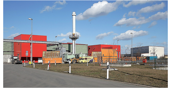
Jährlich 20.000 Tonnen Klärschlamm aus Erfurter Abwässern erzeugen künftig Strom.
