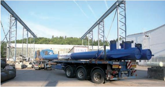
Der Pylon verlässt die Werkstatt in Bischleben, wo er Korrosionsschutz und Farbe erhielt.
