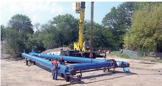
Danach werden die Rohre zusammengesetzt und der Pylon nimmt Gestalt an.
