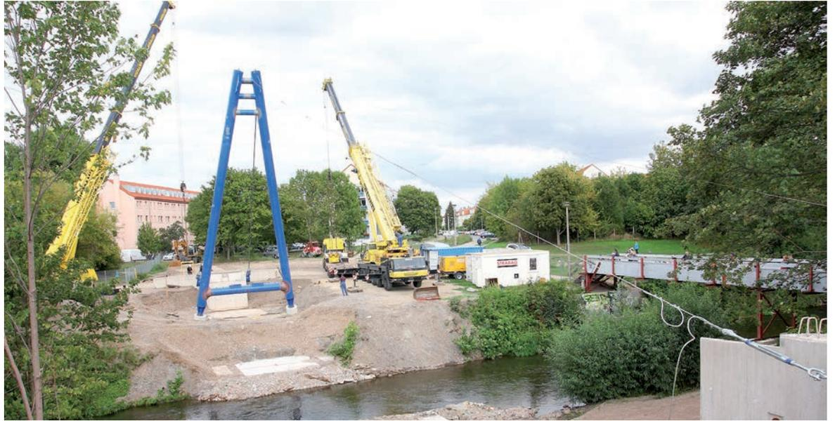
Zwei Kräne haben den Pylon mit seinem Gewicht von 20 Tonnen in die Höhe gewuchtet. Nach und nach werden in den kommenden Wochen die Brückenteile montiert.
