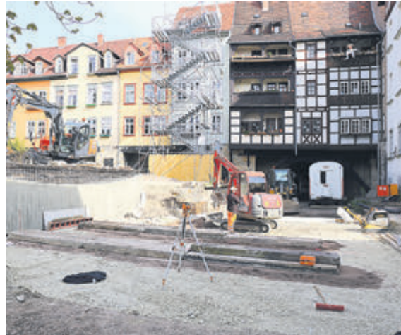
Der Rohbau der östlichen Brücke soll im Juni fertiggestellt sein.
