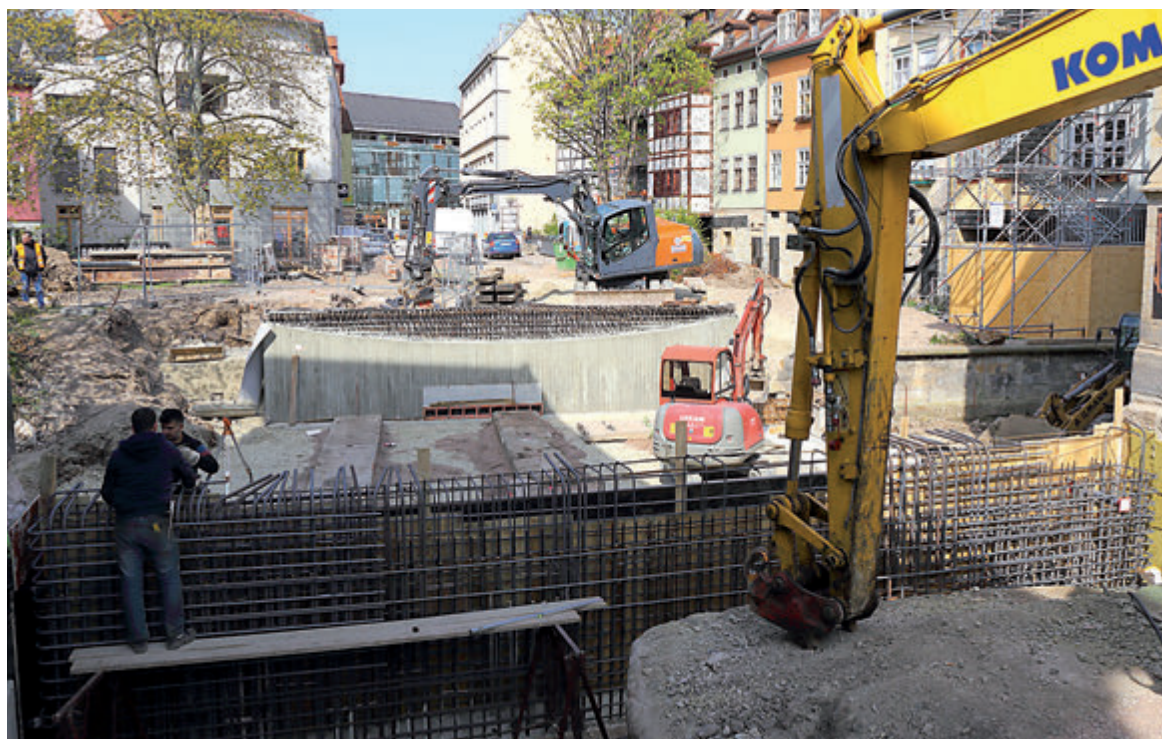
Die beiden widerlagernahen Bäume an der westlichen Brücke bleiben erhalten.
