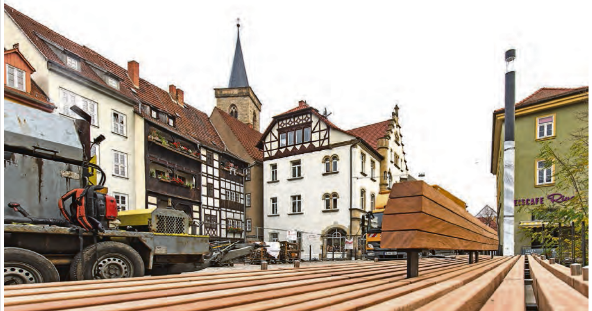
Die letzten Arbeiten auf den Rathausbrücken laufen auf Hochtouren.
