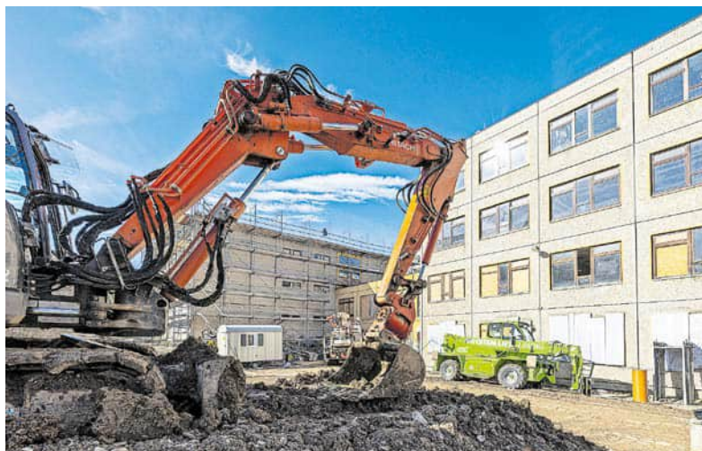
Die Ostfassade wird derzeit von den Arbeiten noch verschont – mit Rücksicht auf die Vögel und Fledermäuse, die hier heimisch geworden sind.
