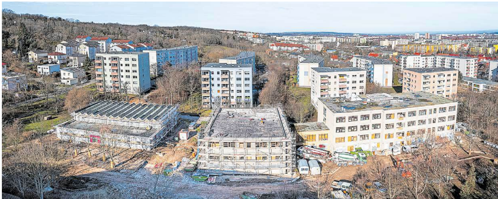
Die Schulbaustelle aus der Luft betrachtet. Während die Turnhalle im Sommer fertig wird, geht für die Arbeiten am Schulgebäude noch einige Zeit ins Land.
