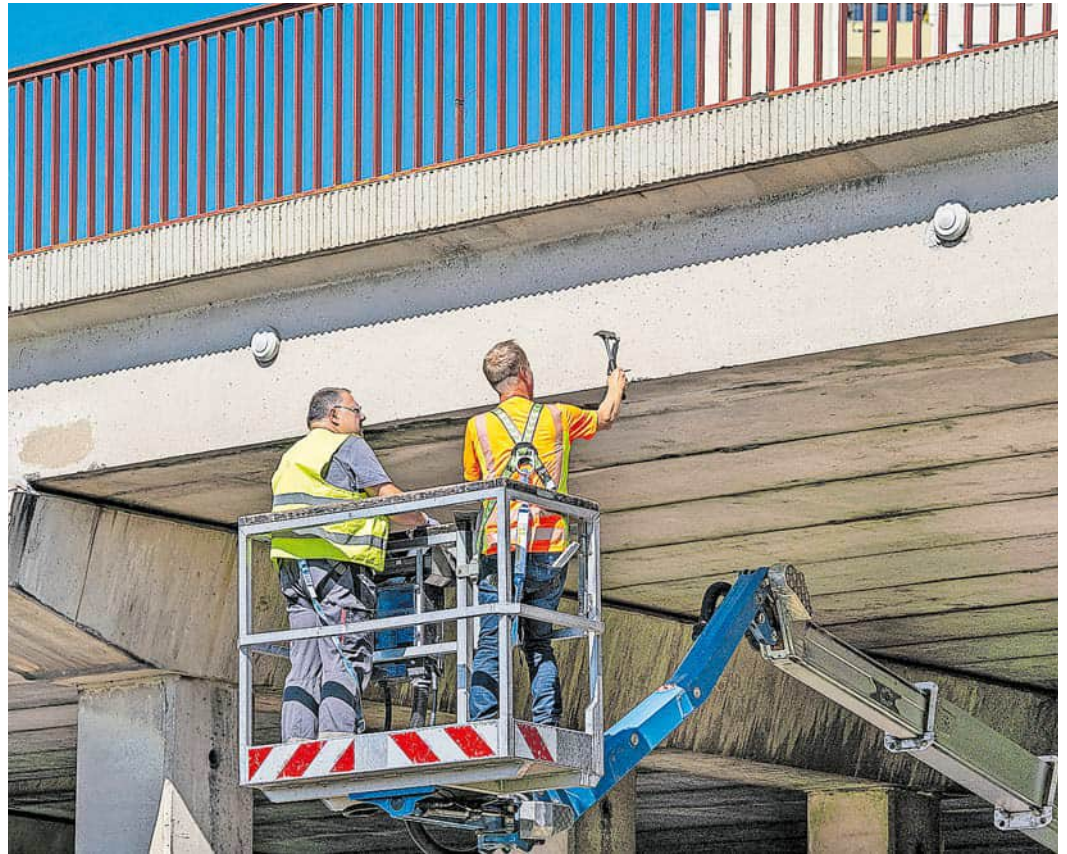
Zwei Mitarbeiter des Erfurter Ingenieurbüros Probst haben den aktuellen Zustand der Brücke kontrolliert und dokumentiert.
