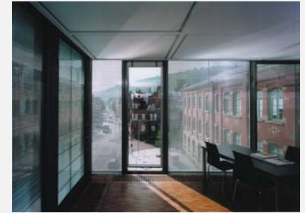
Isolierverglasung mit integriertem Sonnenschutz
