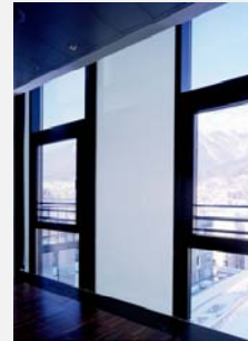
Isolierverglasung mit lichtstreuender, transparenter Wärmedämmung
