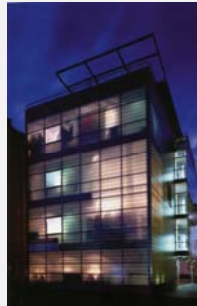
Isolierverglasung mit lichtstreuender, transparenter Wärmedämmung
