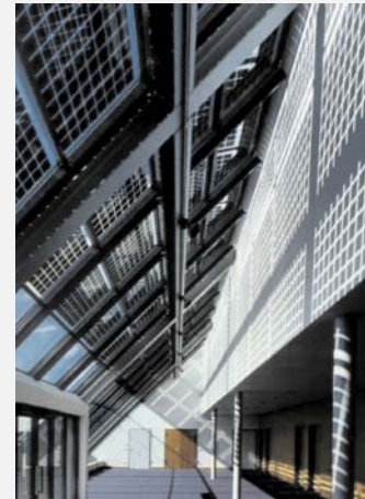
Bundwirtschaftsministerium: Konventionelle Photovoltaikmodule in Schrägverglasung: Hell-Dunkel-Kontraste, Schattenwurf, Blendung
