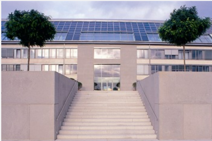
Bundwirtschaftsministerium: Konventionelle Photovoltaikmodule in Schrägverglasung: Hell-Dunkel-Kontraste, Schattenwurf, Blendung
