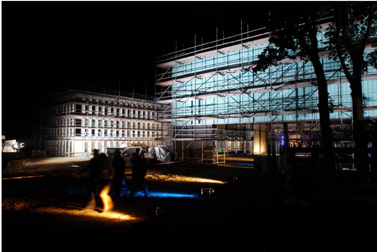
Das Kindermedienzentrum, Rohbau 05.10.2006
