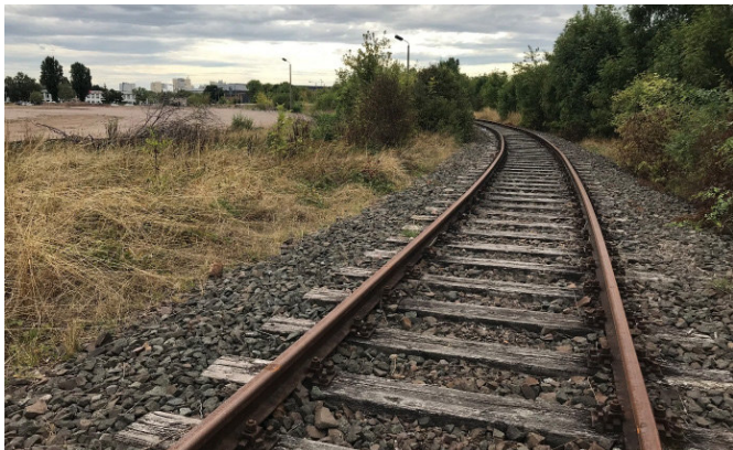
Abb. 3: Ansicht einer selten genutzten Industriebahntrasse im Bereich einer Industrie- und Gewerbebrachfläche im Erfurter Norden. (Aufn. A. Friedel 13.09.2022)
