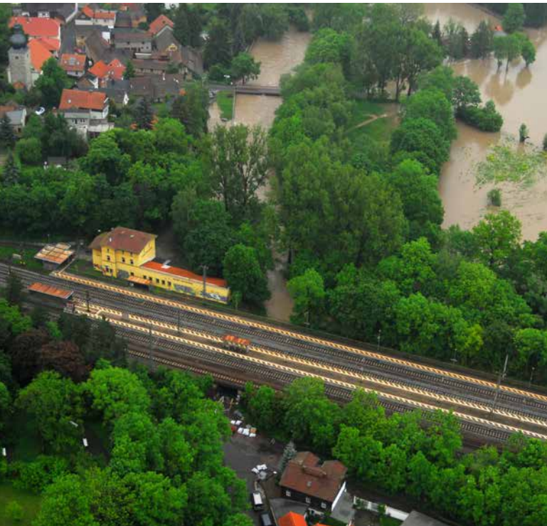
Abb. 1: Hochwasser 2013 am Bahnhof Bischleben
