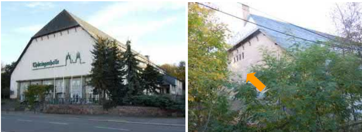
Abb. 7 und 8: Thüringenhalle mit gut angebundener Ausflugsöffnung an der Gebäuderückseite (siehe Pfeil)
