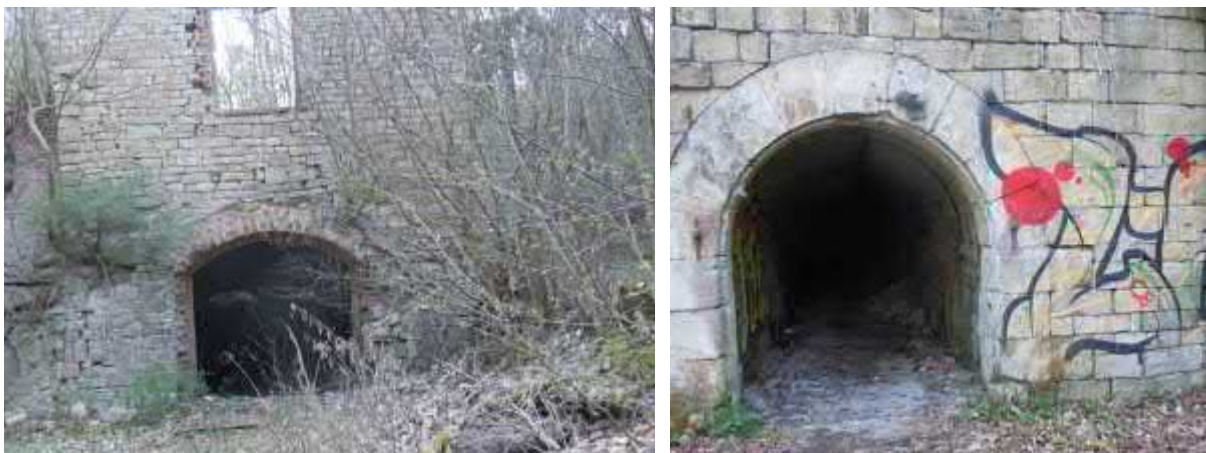
Abb. 3 u. 4: Die beiden Keller an der Arnstädter Hohle werden als Winterquartiere von Fledermäusen genutzt
