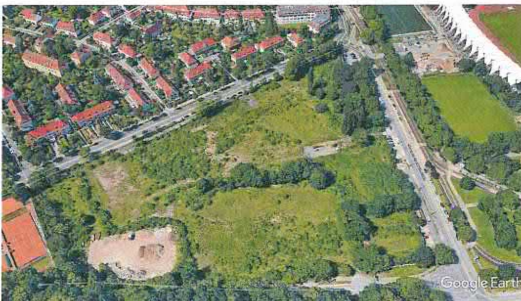
Abb. 1: Luftbild der Lingelfläche gelegen im Südwesten von Erfurt, die von der Martin-Anderson-Nexö-Str. im Norden, der Arndstraße im Süden und der Arnstädter Str. im Osten begrenzt wird. Blick von Süden auf die Fläche (Quelle Google Earth 2018).
