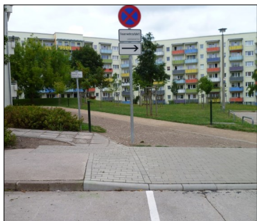
Abb. 11 – Absenkung des Bordsteines
