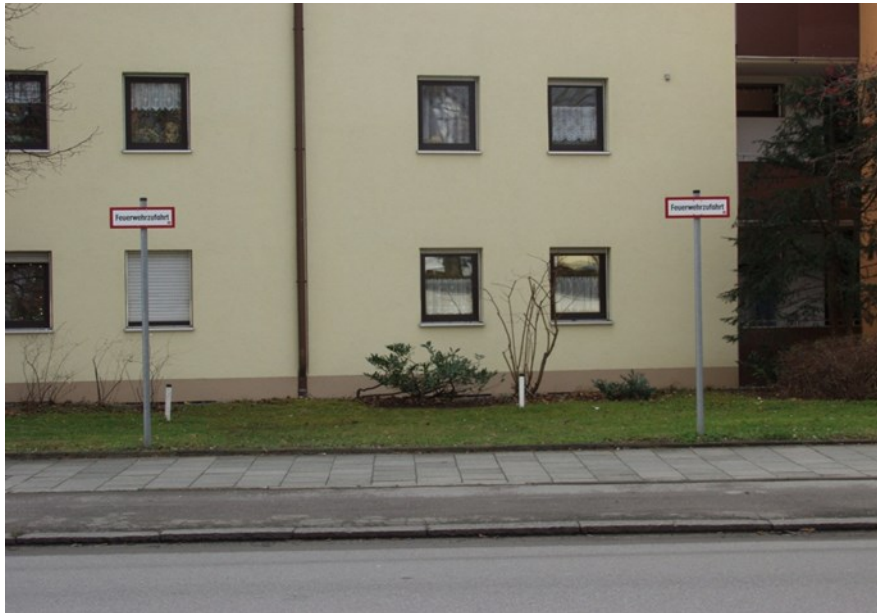
Abb. 25 – Feuerwehrezufahrt über Gehweg mit abgesenktem Bordstein
