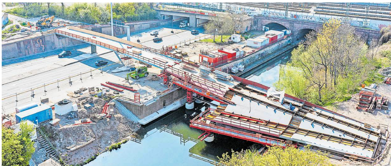
Der Baufortschritt am Promenadendeck aus der Vogelperspektive. Nun fehlen am Überbau nur noch zwei Teile, dann ist er komplett.
