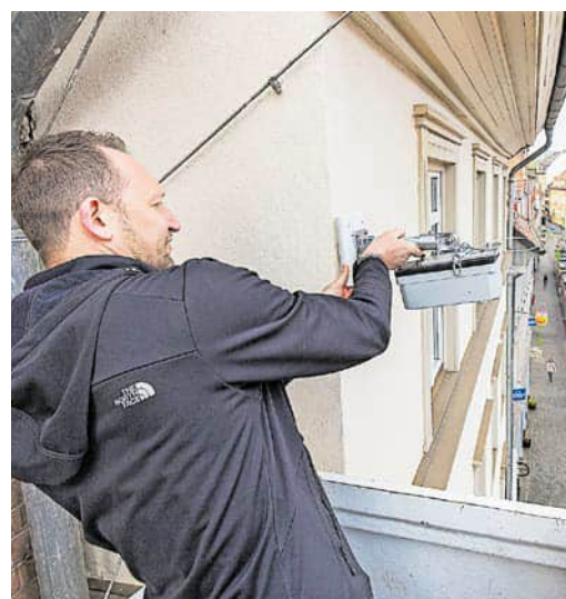
Von unten kaum bemerkt, zählt in 7 Meter Höhe ein Messpunkt die Passanten.
