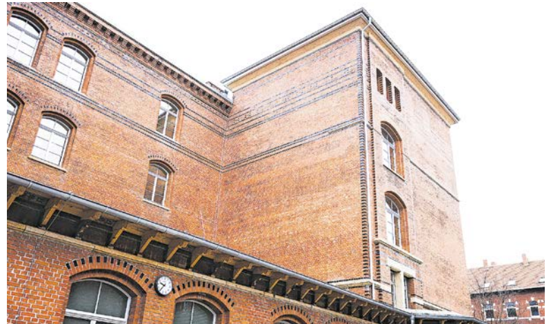
Die Grundschule an der Rosa-Luxemburg-Straße wurde bereits saniert.
