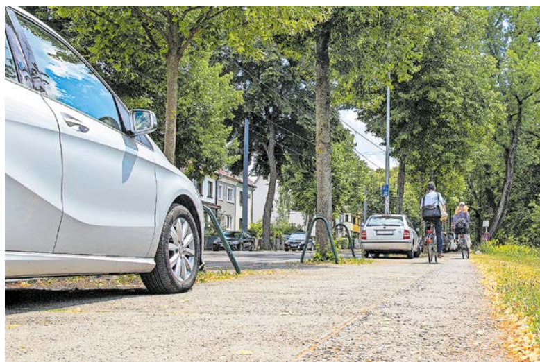
Geh- und Radweg in der Friedrich-Ebert-Straße werden zukünftig voneinander getrennt sein.
