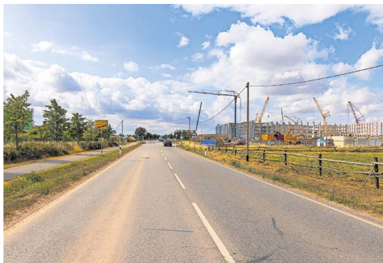
Die Stotternheimer Straße wird saniert, damit sie dem Logistik-Verkehr standhalten kann.
