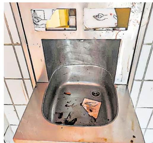
Waschbecken in einer öffentlichen Toilette auf dem Petersberg
