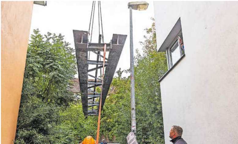
Die schmale Häuserschlucht erschwerte den Aushub der Brücke ...
