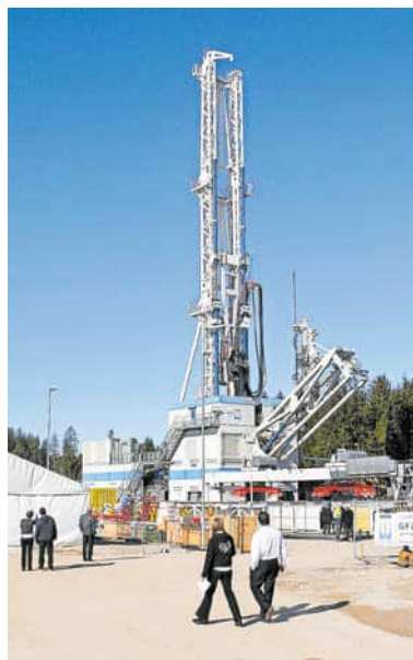
So könnte der Turm für die Probebohrung in Erfurt aussehen.
