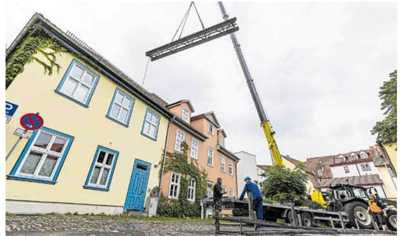
... die sodann vom Kran zum Traktor gehoben wurde.
