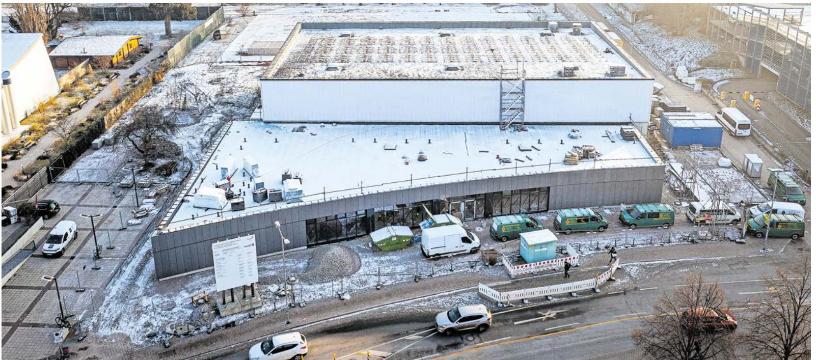
Eines der großen Bauprojekte: Die Drei-Felder-Halle soll im Februar fertiggestellt werden.
