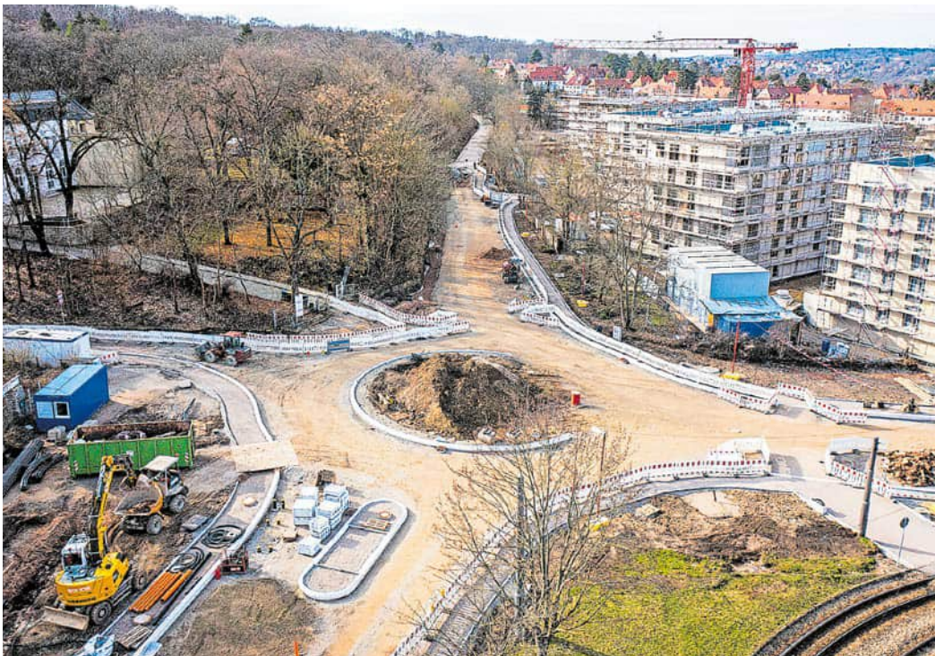
Wenn der Kreisel am Schützenplatz fertig ist, rücken die Bauarbeiten in die Arndtstraße vor.
