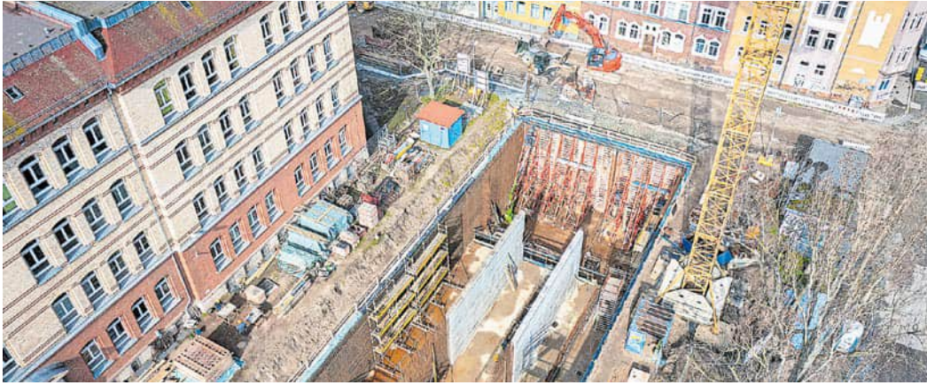
Ein Blick aus der Luft lässt die Größe der Baustelle für das Regenüberlaufbecken erkennen.
