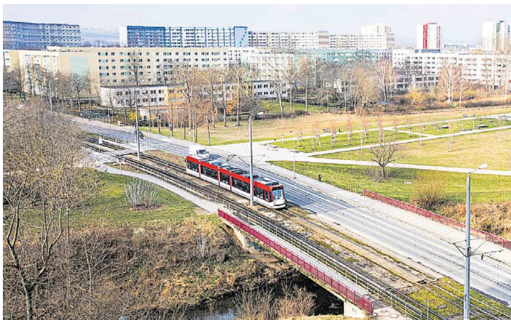
Der Neubau der Brücke in der Warschauer Straße wird im Bauablauf sehr anspruchsvoll – aufgrund der Stadtbahn.
