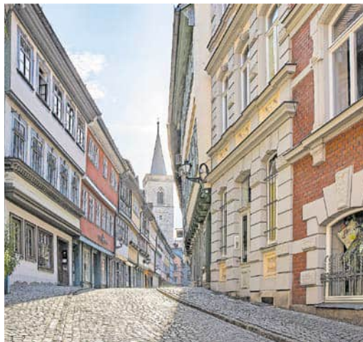
Das Wahrzeichen Erfurts – die Krämerbrücke. Die Erneuerung ihrer „verstaubten“ Elektrik soll Kabelbränden vorbeugen.
