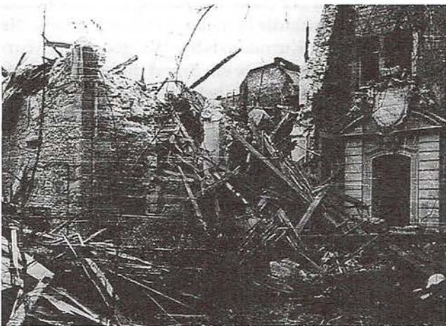
Abb. 60: Das Collegium majus, Michaelisstraße 39, nach der Zerstörung 1945. Zu sehen ist das Quergebäude mit dem Boineburgportal, in dem sich z. Z. die Abteilung „Wissenschaftliche Sondersammlungen“ der Stadt- und Regionalbibliothek Erfurt befindet.
