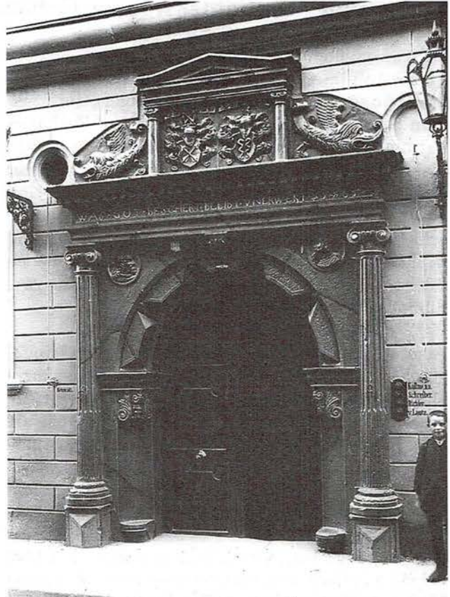
Abb. 61: Das Portal des Hauses „Zur großen Arche Noä und Engelsburg“, Michaelisstraße 38, Aufnahme um 1890
