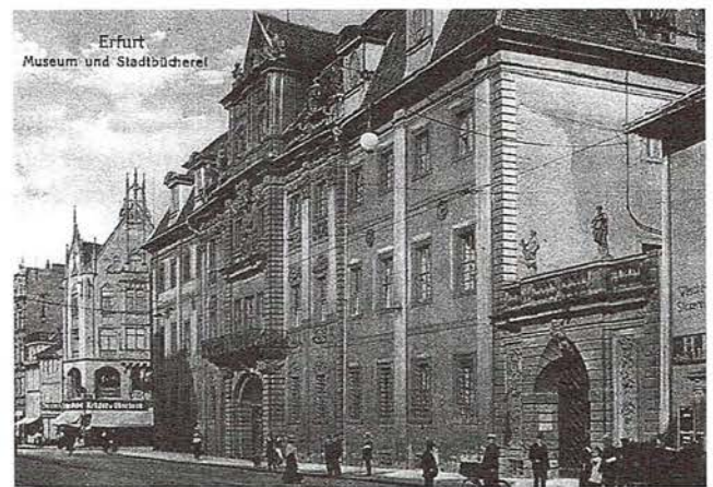
Abb. 58: Die Waage oder Packhof, heute Museum. Von 1883 bis 1936 nutzten Museum und Bibliothek dieses Gebäude gemeinsam
