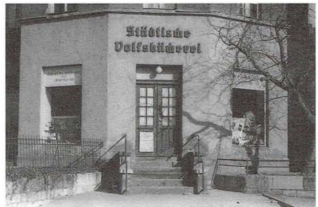
Abb. 18: Außenansicht der Zweigstelle Erfurt-Süd 1953
