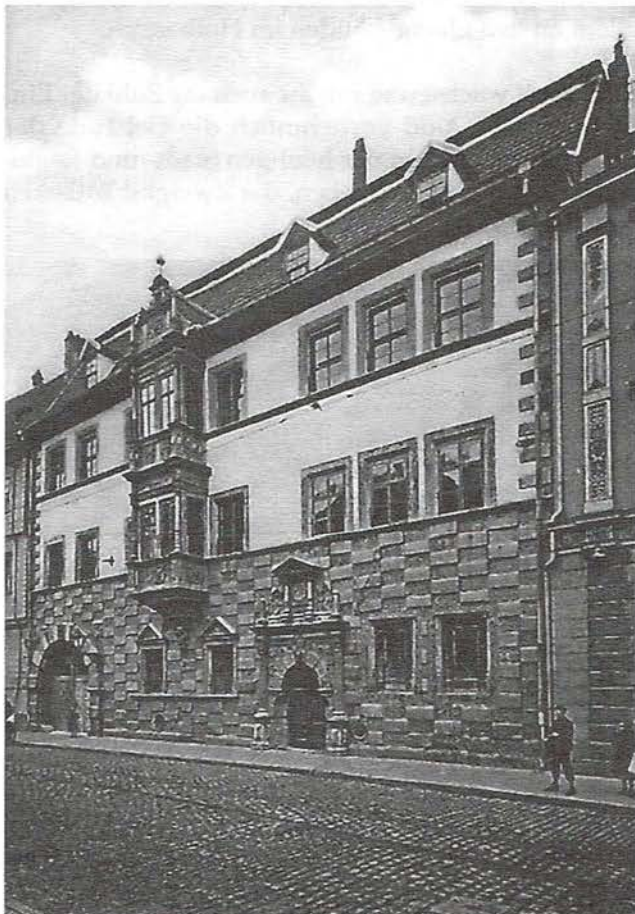
Abb. 64: Straßenansicht „Haus zum Stockfisch“, Johannesstraße 169. Heute beherbergt es das Museum für Stadtgeschichte
