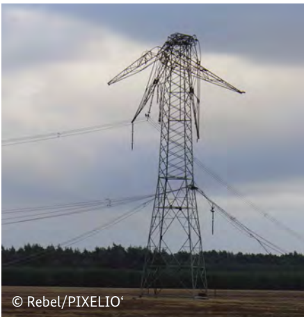
Sturmschaden durch den Orkan Kyrill im Jahr 2007
