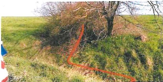
Foto 22 Grabenverschwenkung oberhalb der Gartenanlage mit teilweise zugewachsenem Abflussprofil
