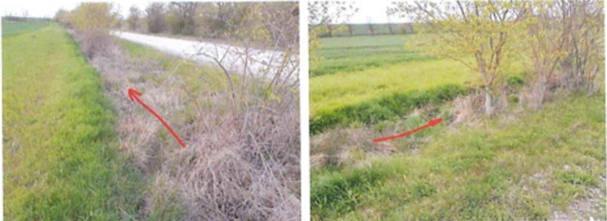
Foto 39 und 40: ausreichendes Abflussprofil bis zum Einlauf in die Verrohrung
