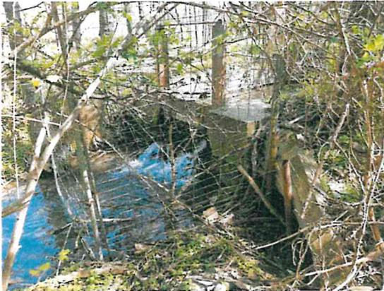
Abbildung 35: Stauvorrichtung mit Dammbalkenverschluss
