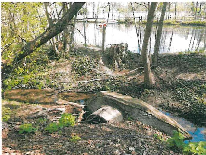
Abbildung 36: ausgebrochenes Einlaufbauwerk
