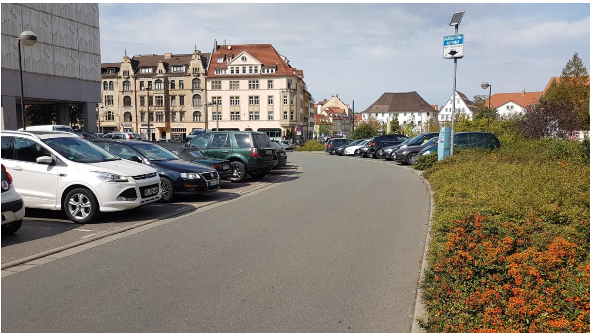
Abbildung 13 Zufahrtsstraße zum Parkplatz an der Neuwerkstraße Foto: G. Weber 10.09.2018
