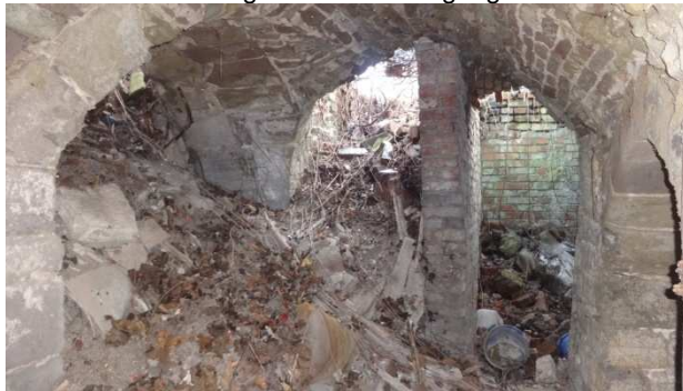
Abb. 3: z.T. in der Decke eröffneter Gewölbekeller
