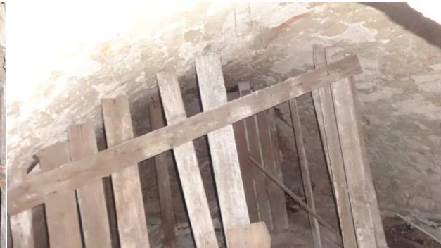
Abb. 4: Blick in den Gewölbekeller
