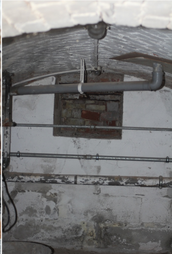
Abb. 11: Keller in der Schmitzstedter Straße 43/44, die Kellerluken
