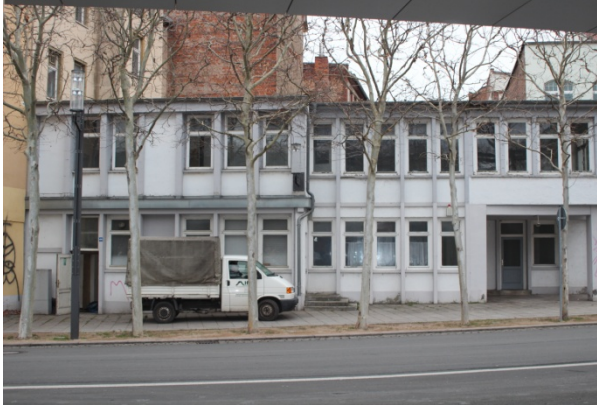
Abb. 12: Straßenseitige Ansicht Gebäude Willy-Brandt-Platz 5.
