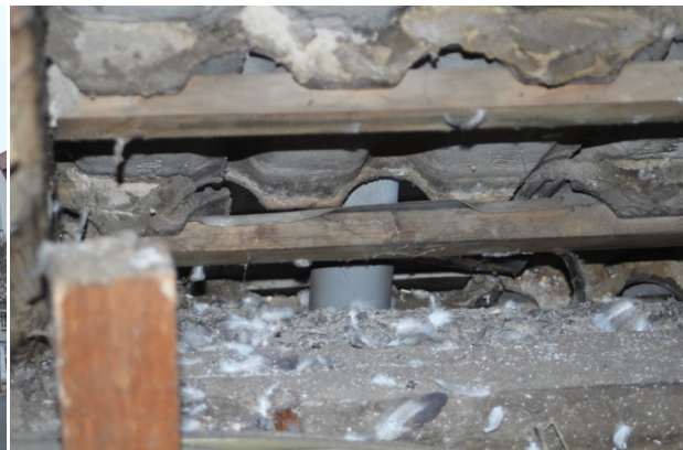
Abb. 9: Einflugmöglichkeit in den Dachboden Schmidtstedter Straße 43/44.
