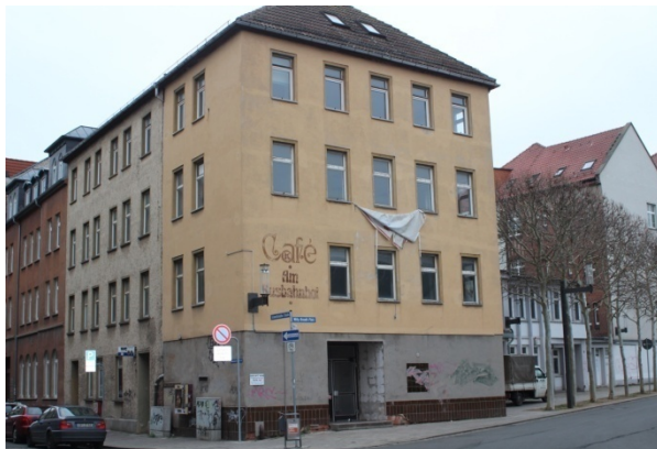
Abb. 8: Straßenseitige Ansicht Gebäude Schmidtstedter Straße 43/44.
