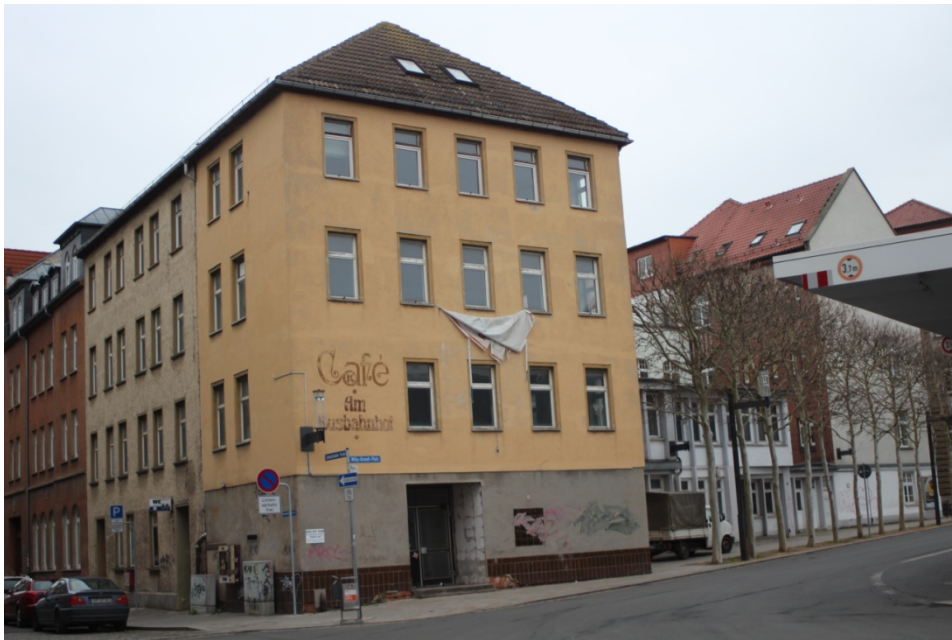
Foto 1: Blick auf die Gebäude der Schmidtstedter Straße 43/44 und Willy-Brandt-Platz 5
