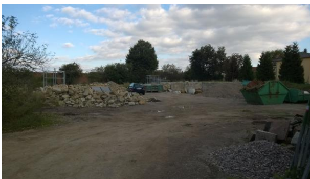
Abb.5: Südteil des Plangebiets
